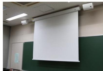
スクリーンは電動式です。プロジェクターのON/OFFに合わせて昇降します。AVコントローラーのボタンによる昇降も可能です。
